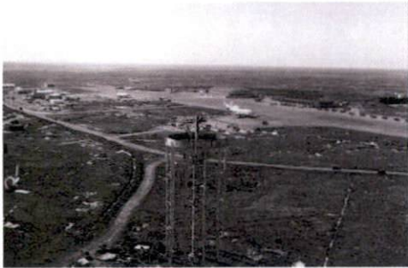
Tankurinn í byggingu 1953
