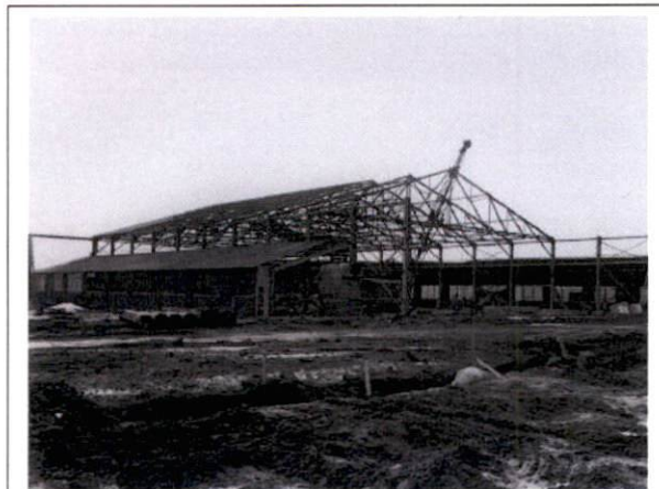
Flugskýli í smíðum á flughlaðinu austanvert í Háaleiti. Sökkklar hússins voru steypptir í metersdjúpum snjó og hvassviðri tafði í tvær vikur að burðargrindin yrði reist. Skýlið var notað til smærri viðgerða á flugvélum sem leið áttu um flugvöllinn og var viðbyggingin notuð um tíma sem flugstöð. Flugskýlið hýsir nú flugþjónustudeild Keflavíkurflugvallar.
